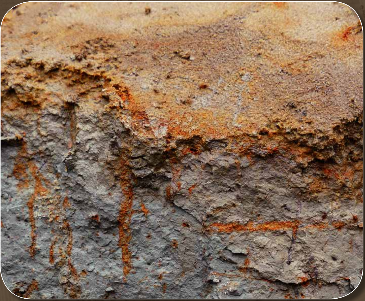
Je ziet heel duidelijk de roestkleur op de kleilaag. Het insijpelend water neemt de ijzerdeeltjes mee naar beneden, maar geraakt niet door de ondoordringbare kleilaag. Het ijzer hoopt zich op en vormt de typische roestkleur.
