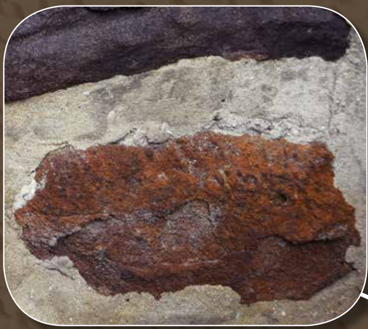
De kerk van Adinkerke ligt op een boogscheut van de locatie van de monoliet. Bij de bouw maakte men gebruik van ijzerzandsteen uit de omgeving. Ijzerzandsteen ontstaat door het samenklitten van zandkorrels door ijzerdeeltjes (limoniet). Door inwerking van de lucht oxideert het ijzer en krijgt het een donkerbruine kleur.
